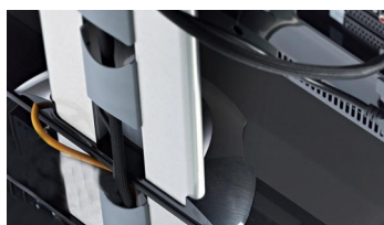
Detailansicht: Kabelführung Rückseite
